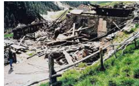
Das im Jahre 1986 durch eine Staublawine zerstörte Rableidanwesen
