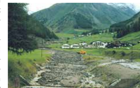
Das übervolle Bachbett nach den Unwetterereignissen im Spätsommer 1977 (Vernagtmure!).
